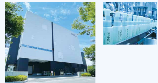
「マイルドクレンジング オイル」の新工場
